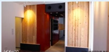
**特長** 1CLTによる耐力壁・床板と集成材による柱・梁を組み合わせたフレーム構成した準耐火建築物。耐力壁の上下階接合はGIR接合とする事で金物を壁内部に納め、片面を燃えしろ設計によるCLT現しとしています。
