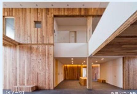
**特長** 木造軸組工法+CLTの利用。CLTは壁の耐力壁としての利用を図るとともに、大臣認定の取得により、CLT現しによる準耐火構造の壁としている。この他、床や屋根の軒にもCLTを採用。
