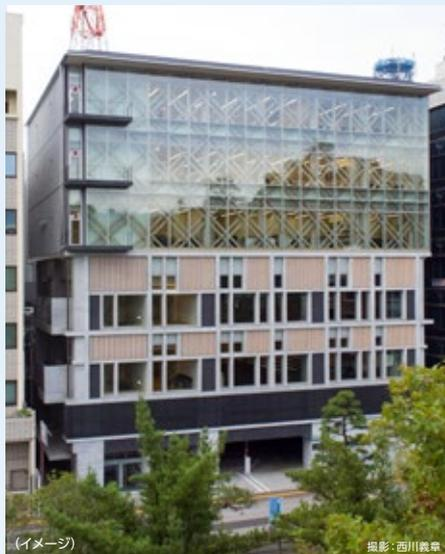
**特長** 1階2階の中間に免震層を設け、1～3階がRC造、4～6階が耐火木造の中層庁舎ビル。木造部分の耐震要素は木材を木製ブレースと面材耐力壁で構成し、高耐力を必要とする面材耐力壁にCLTパネルを使用。
